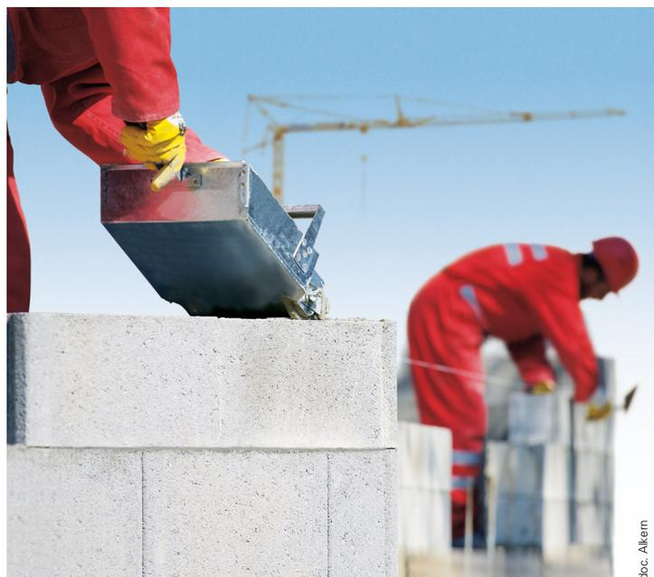
La mise en œuvre des joints minces des blocs de béton ALKERBLOC d'Alkern est simple et rapide.
